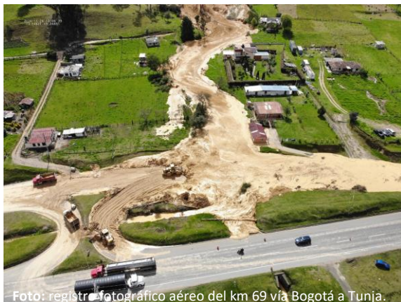
Foto: registro fotográfico aéreo del km 69 vía Bogotá a Tunja.
